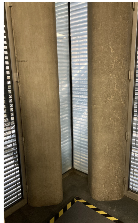
Menuiserie type B - photo état existant
